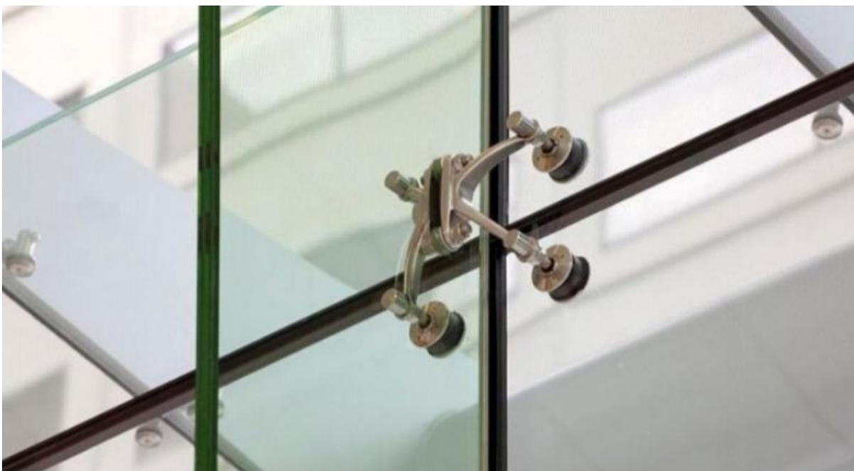
O sistema de Vidro Exterior Agrafado, ou Spider Glass, utiliza conectores pontuais (geralmente em forma de aranha) para fixar as placas de vidro à estrutura de
