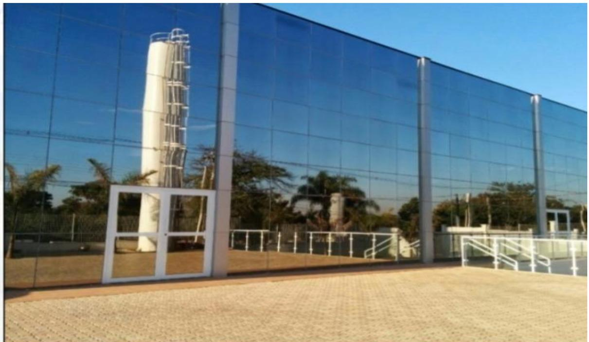
A Pele de Vidro é um sistema em que os painéis de vidro são fixados diretamente à estrutura do edifício, com perfis metálicos visíveis. Ao contrário da Cortina de Vidro, a Pele de Vidro tem um caráter mais estrutural, sendo muitas vezes aplicada em camadas exteriores às paredes de alvenaria. É uma técnica de revestimento de fachadas que consiste em cobrir a estrutura de uma edificação com vidro.
