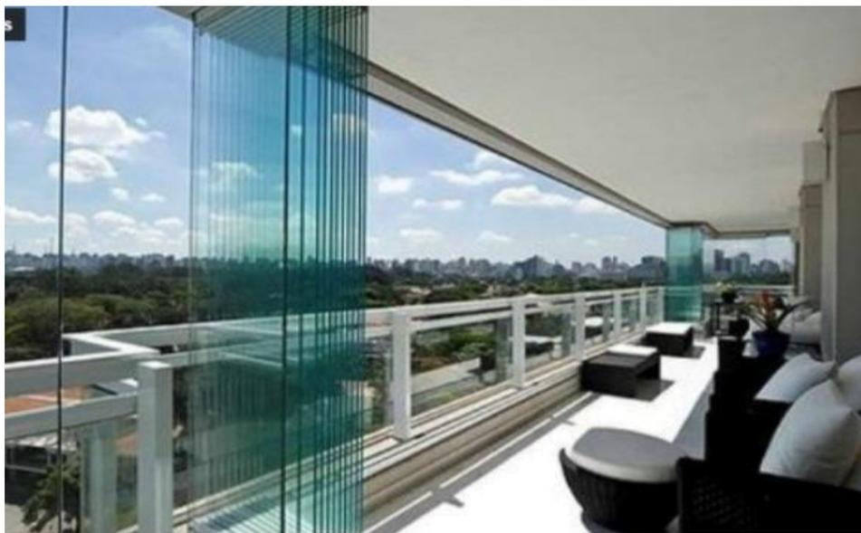
A Cortina de Vidro é um sistema em que as fachadas são construídas com painéis de vidro instalados externamente, sem que suportem o peso estrutural do
