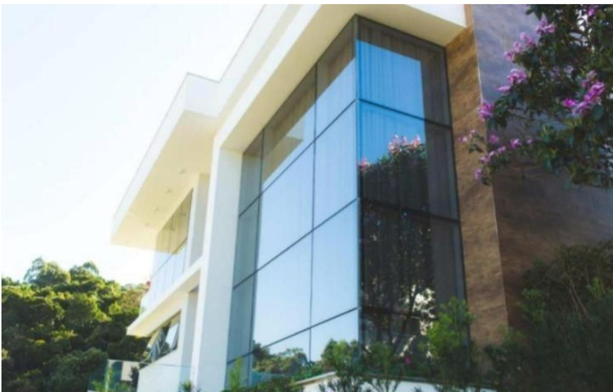
O sistema Estrutural Glazing é caracterizado pela fixação dos vidros diretamente à estrutura do edifício com o uso de silicone estrutural, eliminando a
