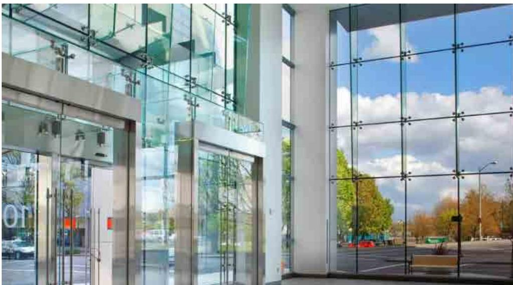
**FIGURA 4 - Exemplo de aplicação de fachada Spider**
