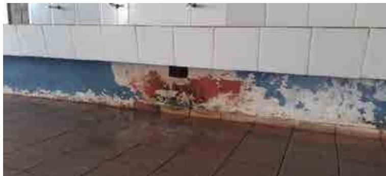
Figura 3: Parede do bebedouro com problema de infiltração de umidade.
