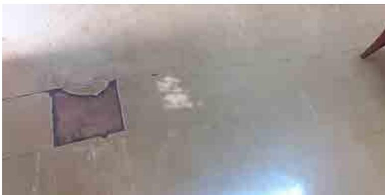
Figura 5: Descolamento de placas cerâmicas
