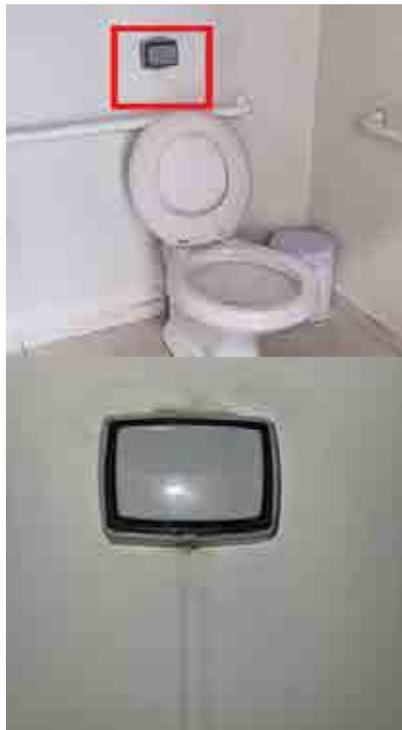
**Manifestação Patológica:** Vazamento em válvula de descarga
