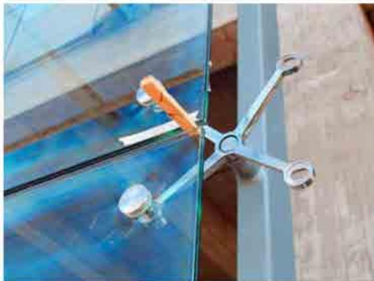
**FIGURA 3 - Detalhe de fixação dos vidros na estrutura do Spider**
