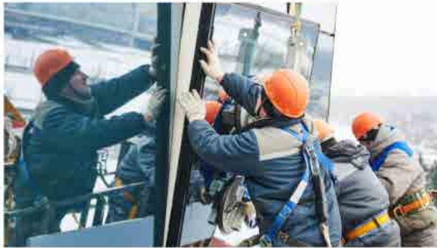
**FIGURA 5 - Instalação de painel de fachada glazing sistema Stick**
