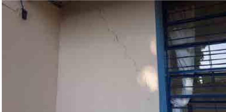
Figura 2: Fissura na parede externa
