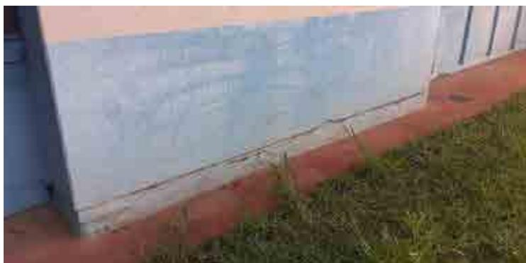
Figura 1-b: Fachadas externa com incidência de fissura contínua
