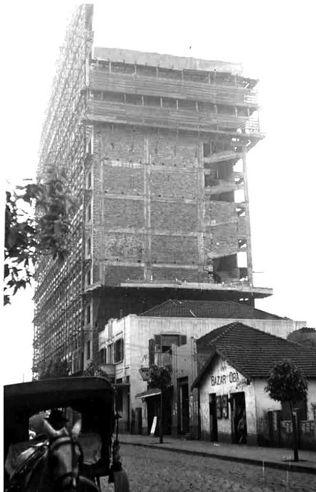
Edifício Tócio em construção na Rua Sergipe, ao lado o Bazar Oba.
