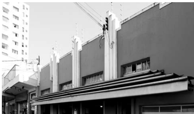
Platibanda observada logo abaixo da edificação. Foto: Rei Santos 2012.
