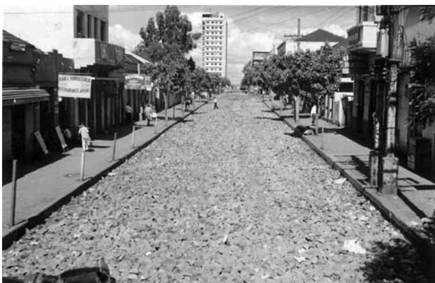
Rua Sergipe partindo da Rua Pernambuco, em preparo para o asfaltamento. Novembro de 1958 | Foto: Oswaldo Leite. Acervo Museu Histórico de Londrina Pe. Carlos Weiss.
