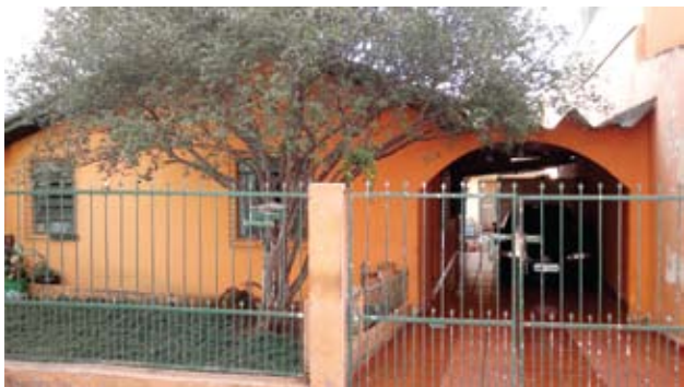
Figura 11: Casa de conjunto habitacional com pequena alteração no projeto original, acrescida de uma garagem e pintada com uma cor intensa, contrastando com a cor original predominantemente branca. Notar a solução em arco do espaço da garagem. 2013. Foto: Pedro Botti. Acervo do autor.
