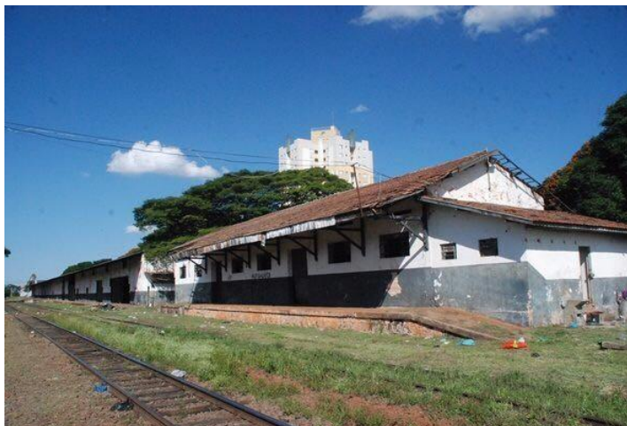
Figura 01 – Estado atual dos galpões da pátio ferroviário
