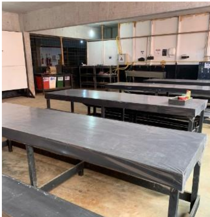
Figura 10 – Refeitório no interior da edificação (obra 1).
