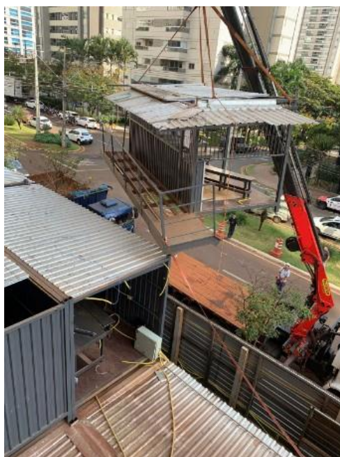
Figura 4 – Container sendo retirado da obra
