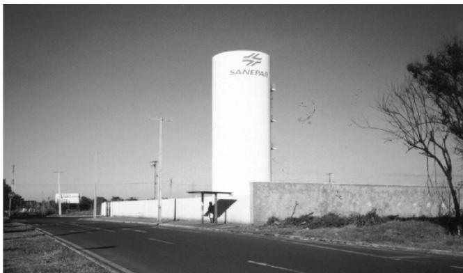
Foto 05: Um dos reservatórios elevados de distribuição de água tratada.
