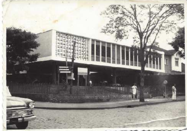
Figura 4 - Residência Mário Fuganti. Década de 1960.
